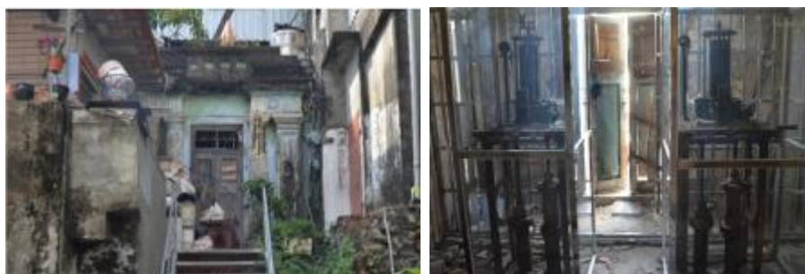
▲ 打狗水道淨水池（量水器室）具高度工藝價值
