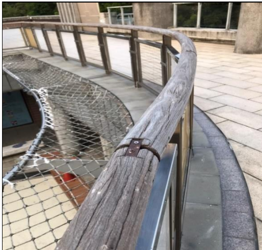
兒美館 2F 木製扶手欄杆長年風吹日曬雨淋導致欄杆損壞，影響美觀及安全
