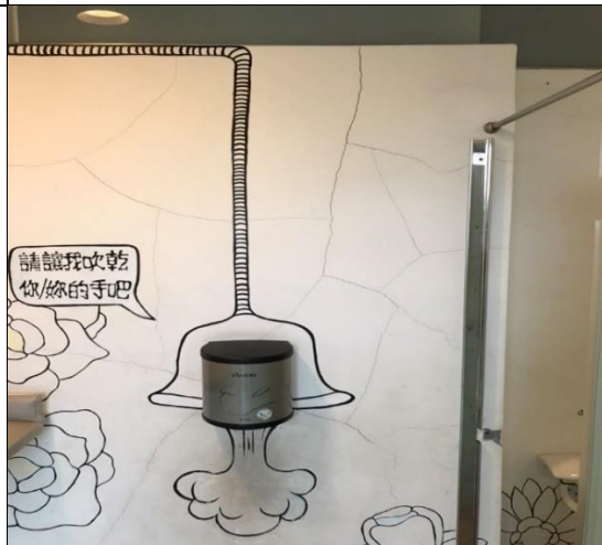
兒美館 2F 親子廁所因磁磚脫落凹陷處容易卡汗 垢，變得難以清掃還會積水在裡面。
