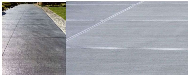
以 RC 刷毛鋪面施作
