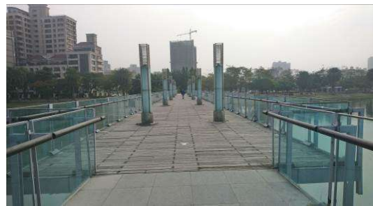
現況燈具全數損壞，木棧平台腐朽
