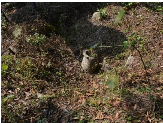
照片 1 庭園內下陷坑洞
