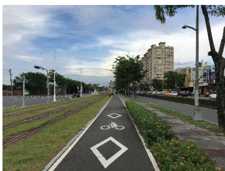
⑬前鎮街至鎮興路自行車路線狀況良好·唯部分路段喬木栽植稀疏遮蔭不足。
