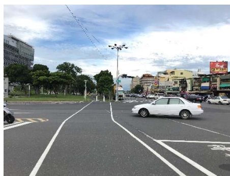
⑪凱旋路與成功二路交叉口車道路幅大·自行車穿越時易有交通衝突產生·目前設有自行車號誌卻未亮起·應改善。
