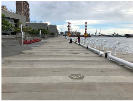
⑤ 自行車道與人行空間共用，以地面標示界定，並設有自行車停車空間。
