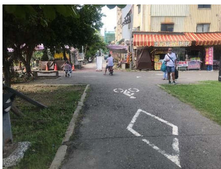
⑤ 路口標示不明確，需增設標示指示方向。
