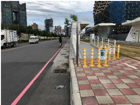
⑧ 因港埠旅運中心施工中，及輕軌建置完成，目前自行車需騎乘於車道上，易有安全問題。
