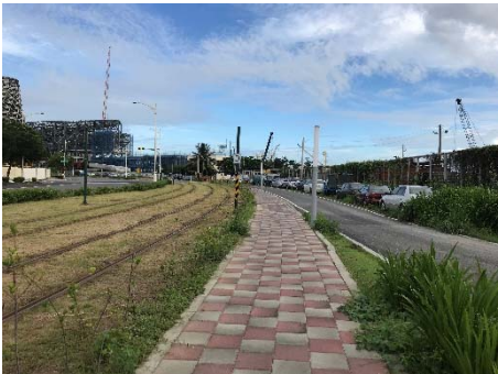
⑦ 此段目前為施工路段，自行車道不明確，暫需騎乘於人行道上，易與行人衝突。
