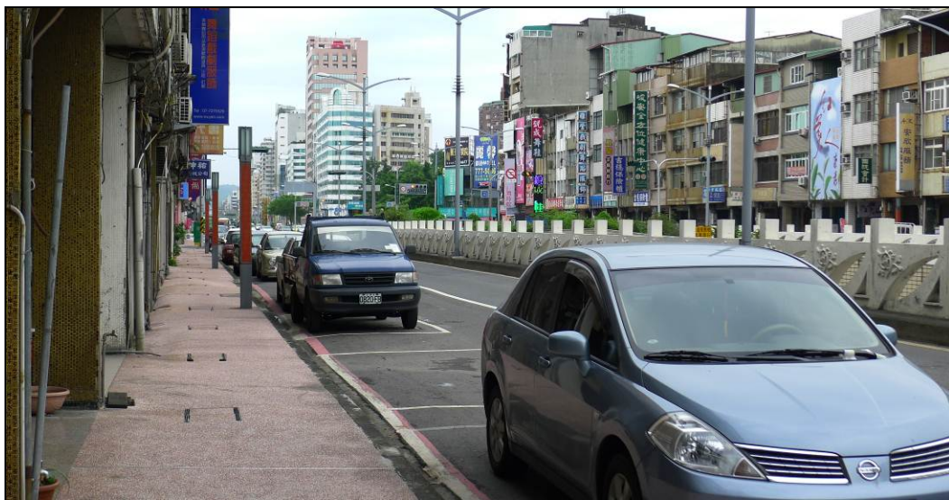
圖 2.4-5 中正一路南側人行道現況(大順路以東)
