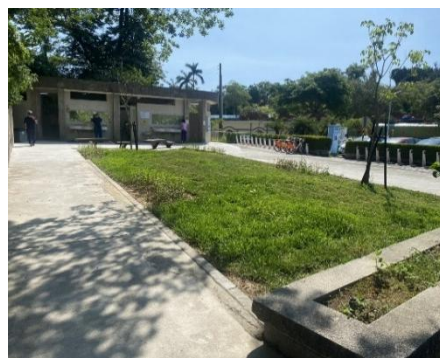
澄清湖迷宮花園販賣部(A棟)拆除後現況
