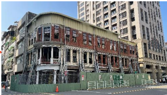
原鹽埕町二丁目連棟街屋修復工程
