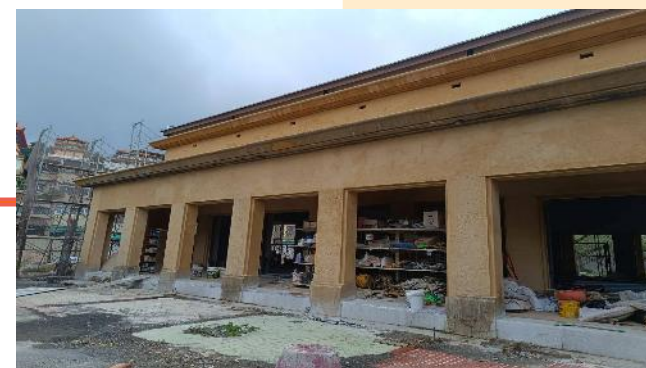
田町齋場修復工程
