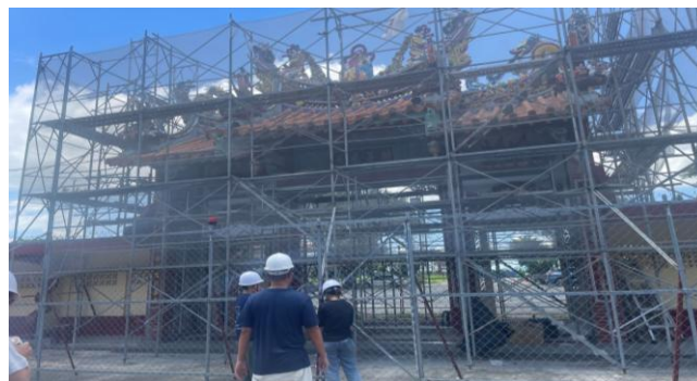
美濃輔天五穀宮修復工程
