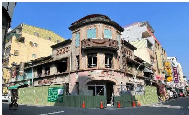
鹽埕町五丁目22番地原友松醫院修復工程
