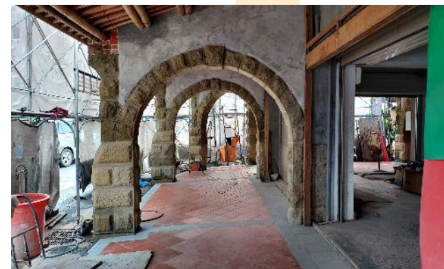
旗山亭仔腳(石拱圈)修復工程
