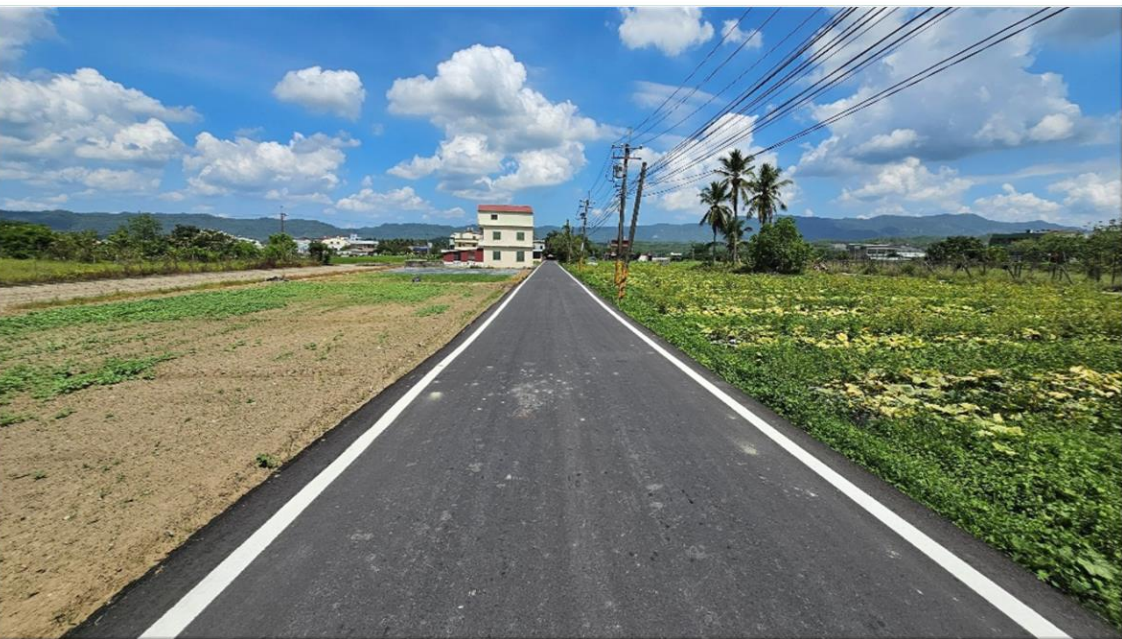
杉林區清水路中學巷1號前路面
