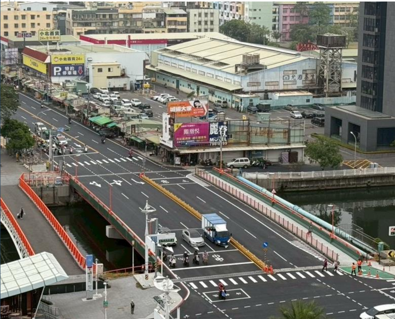
前鎮媽祖港橋改建工程
