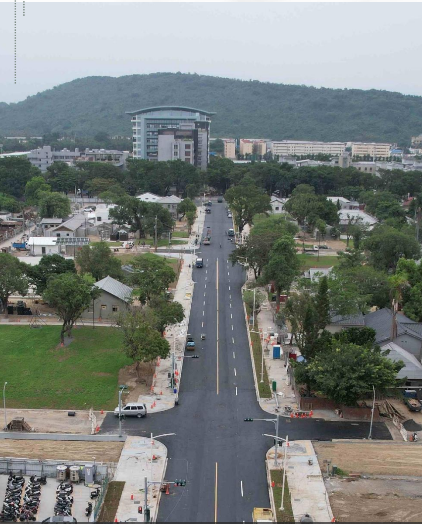
左營區緯六路拓寬工程
