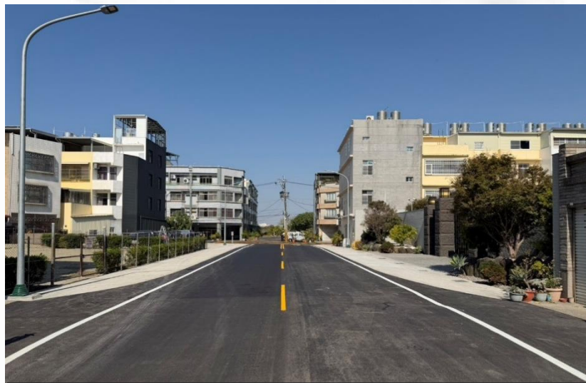
茄萣區和平路三段開闢工程
