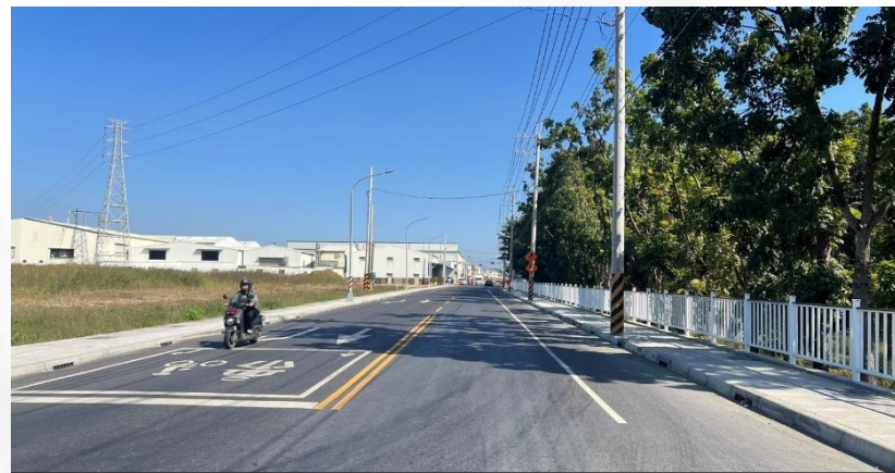
仁武區仁心路道路拓寬工程(第一期)
