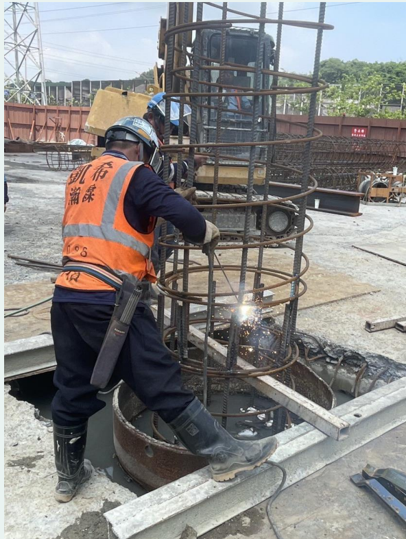
通風豎井中間樁施作
