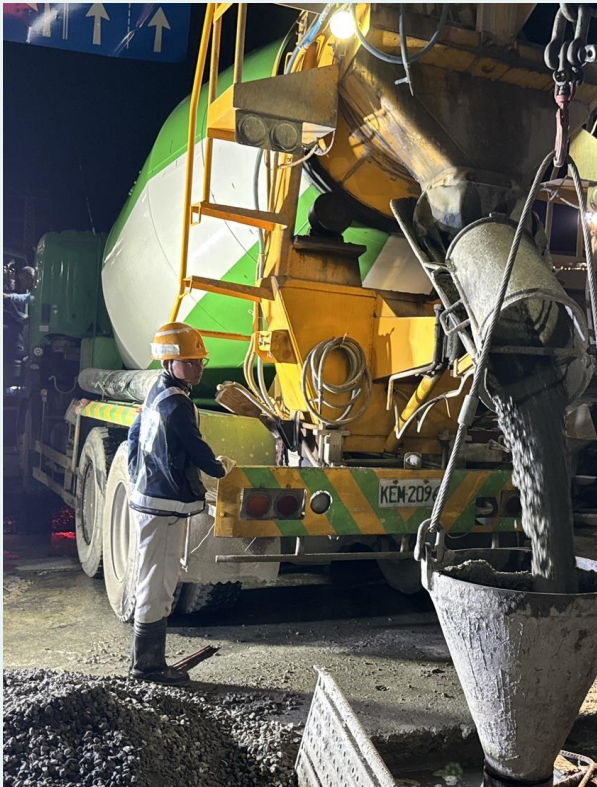
通風豎井混凝土澆置
