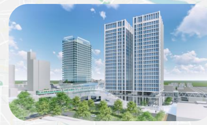
RK1(西) 岡山站 達麗建設
