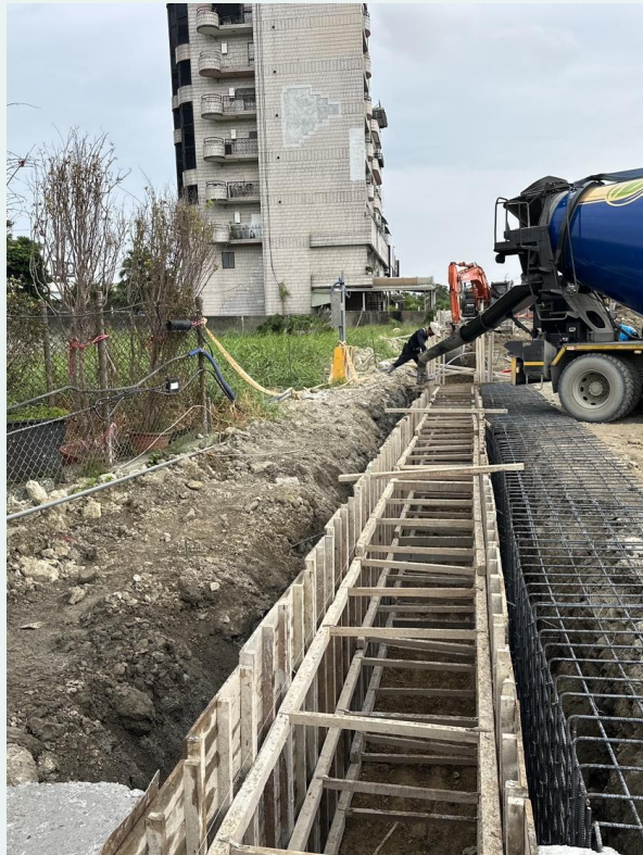
Y3站導溝牆灌漿
