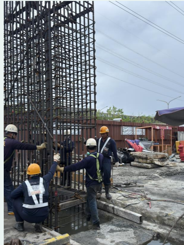
通風豎井鋼筋籠搭接
