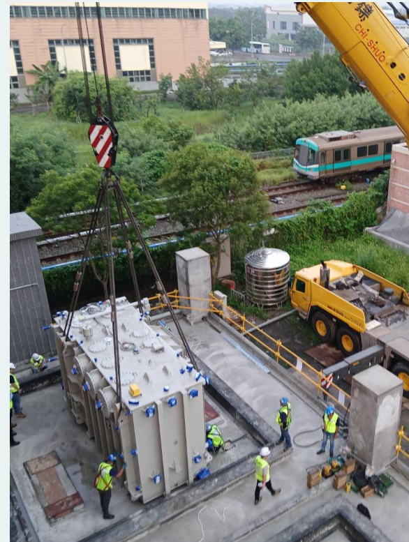
能源調度中心 大型設備吊裝定位
