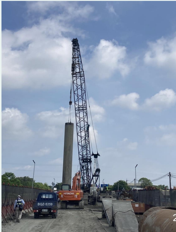
全套管基樁施工
