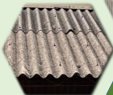
石綿浪板 屋頂/雨遮
