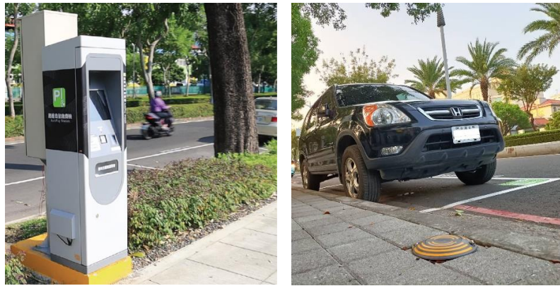
圖 12 繳費機及智慧停車設備
