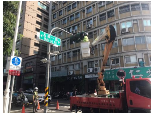
圖 5 號誌維修高空作業
