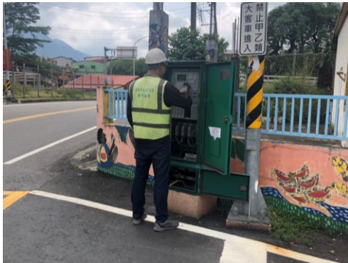
圖 4 號誌控制器線路查修
