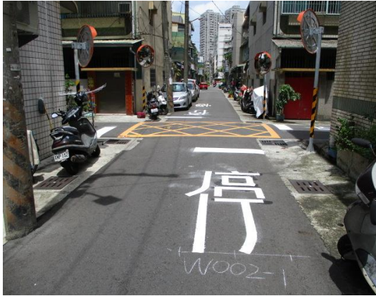
圖8 左營區龍德路83巷增設停止線及「停」標字
