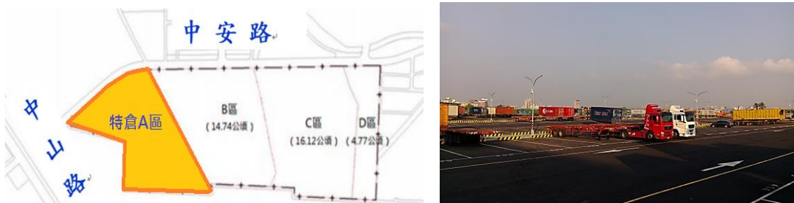
圖 19 特倉 A 區設置大型車公共停車場、第 1 期完工照
