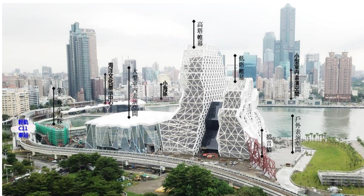
圖 2-實際施工照片
