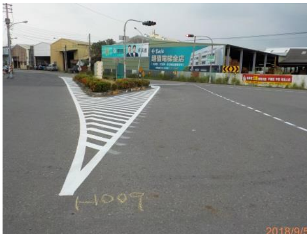
圖 46 大寮區成功路(高 61) 劃設槽化線、導引線
