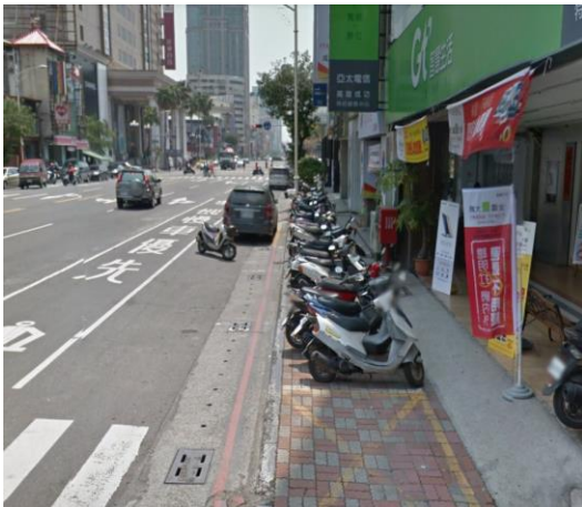
圖 20 苓雅區成功路施工前
