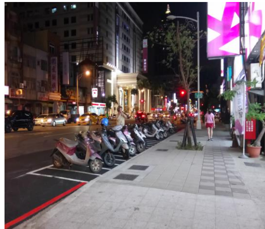
圖 20 苓雅區成功路施工後
