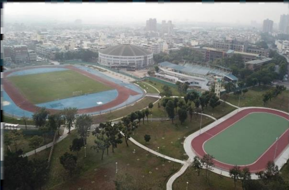
鳳山運動園區 108. 12全區完工
