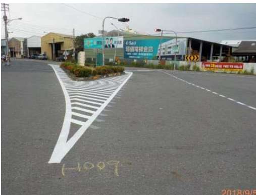
圖 46 大寮區成功路（高 61） 劃設槽化線、導引線
