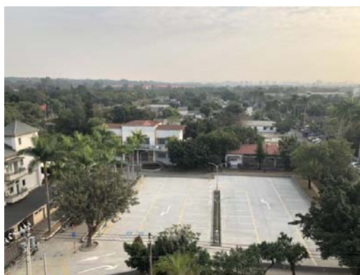
圖 8 鳳山區－黃埔新村公有停車場
