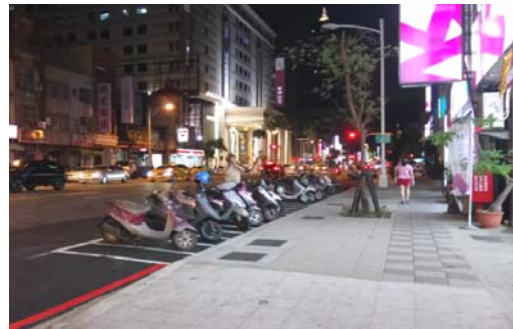
圖 19 苓雅區成功路施工後
