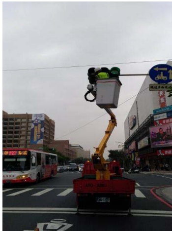
圖 42 號誌維修作業-1
