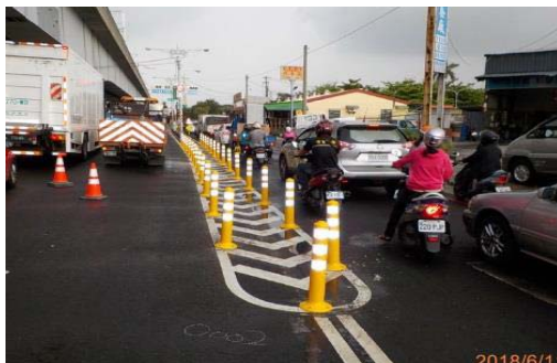
圖 43 仁武區水管路東向近水管路 增設軟質分隔桿
