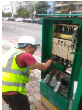
圖 42 號誌維修作業-2
