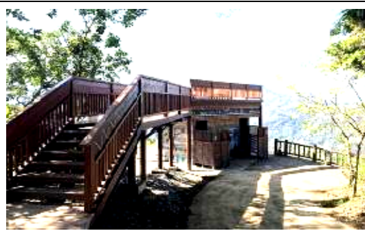
那瑪夏區觀光遊憩設施整建工程
