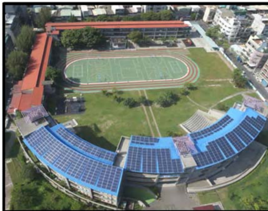
高雄市鳳山區文山國民小學校舍屋頂光電設施 (圖片來源：高雄市政府工務局 2016 建築物設置太陽光電成果專輯)
