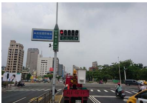
圖 58 新興區中山/五福路口號誌管線下地
