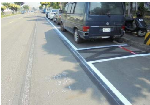
圖 30 平和西路新設汽車停車位
