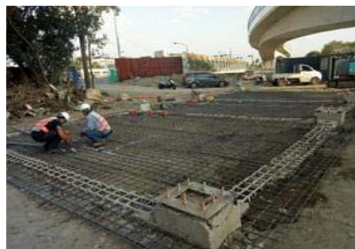
圖 92 前鎮輪渡站施作地坪排筋
