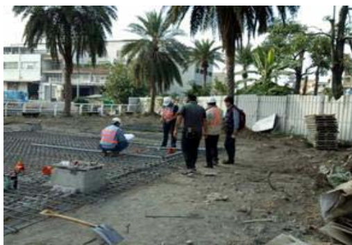
圖 92 前鎮輪渡站施作管線
