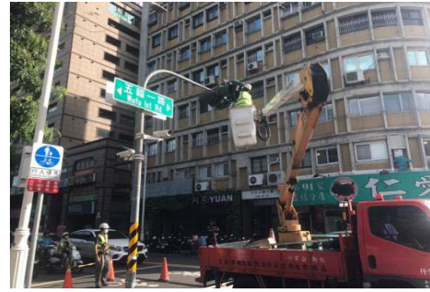
圖 5 號誌維修高空作業
