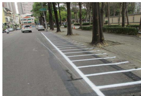
圖 64 前鎮區民瑞街新設機車停車位
