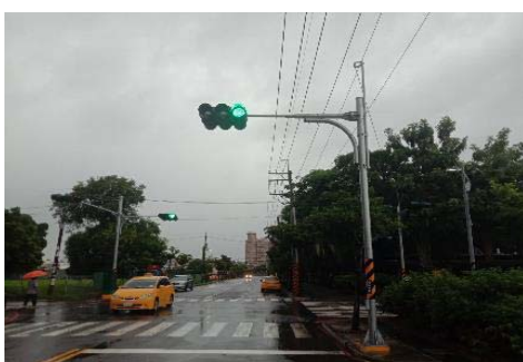
圖 2 岡山區空醫院路與樹人路增設三色號誌
