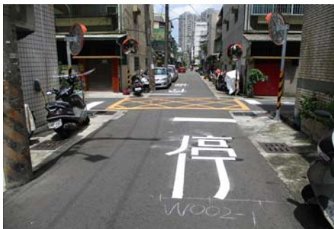
圖 8 左營區龍德路 83 巷增設停止線及「停」標字
