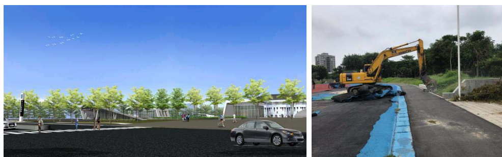
圖 56 鳳山運動園區地下停車場模擬圖暨施工照（地上物拆除）
