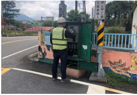
圖 4 號誌控制器線路查修
