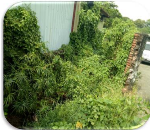
烏松區松埔北巷排水溝自渠底生長出樹木
