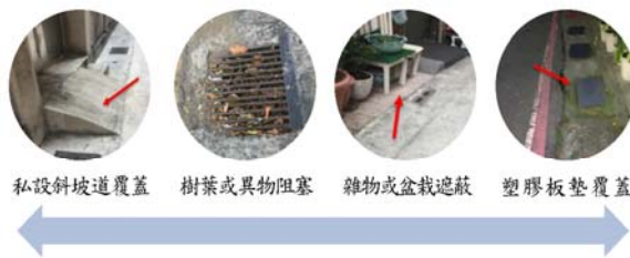
圖7 排水設施之部分洩水孔或清掃孔實況圖
