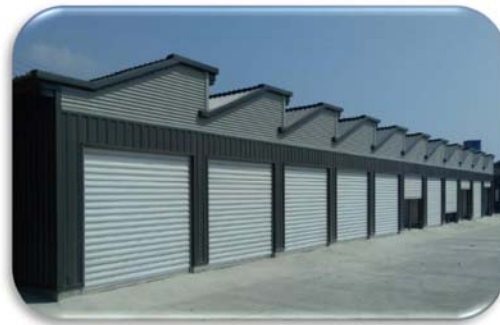
興建完成之中芸漁港整補場大型漁具間
