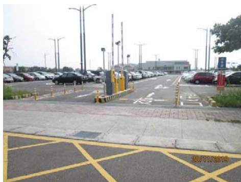
圖 59 岡山區—高雄捷運 R24 南岡山站第一停車場
