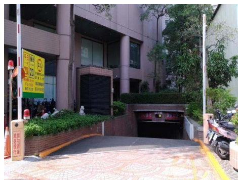
圖 60 三民區—霖園高雄商業大樓停車場
