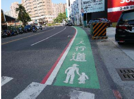
圖 12 三民區明仁路劃設標線型人行道
