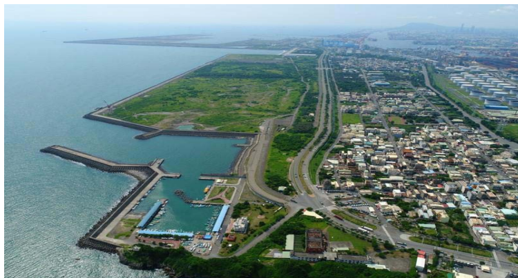
圖 2.新材料循環產業園區空拍圖
