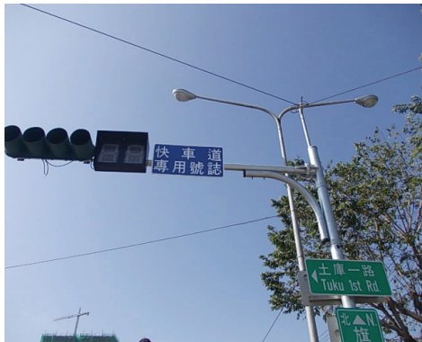
楠梓區土庫一路附掛快車道專用號誌標誌牌
