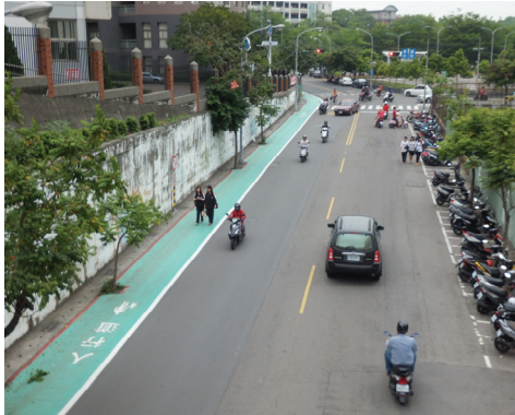
仁武區正修科大前設置標線型人行道
