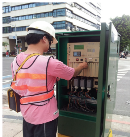
號誌維修作業
