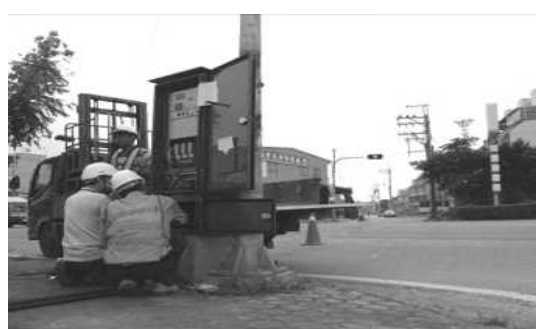
號誌控制器更換作業
