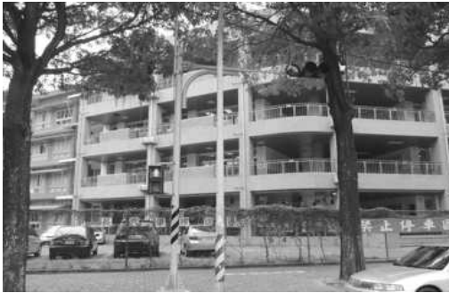
楠梓區東寧路新設號誌
