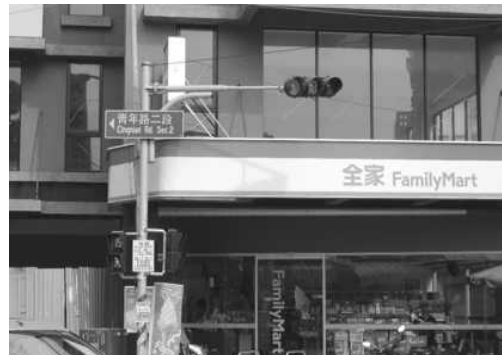
鳳山區青年路二段新設號誌
