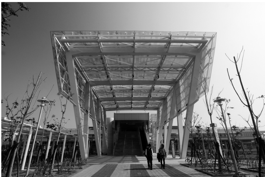
R24 車站 1 號出入口鋼構玻璃造型
