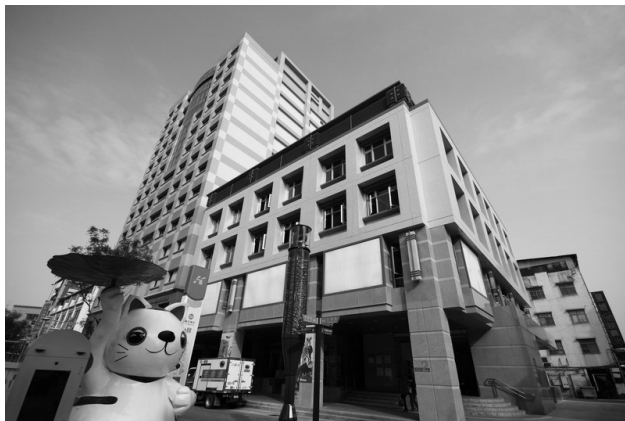
02 鹽埕埔站出入口 B 共構大樓現況
