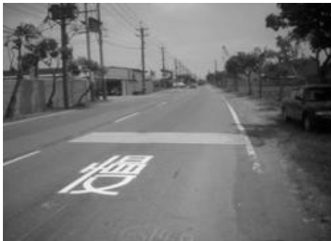
林園區溪州二路增繪減速標線及慢標字
