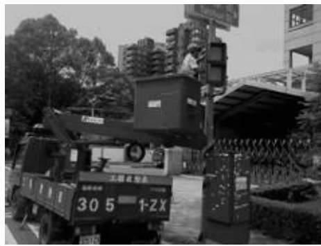
行人號誌維修作業
