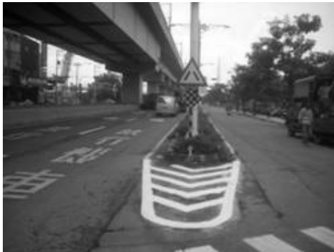
仁武區鳳仁水管路口增繪槽化線
