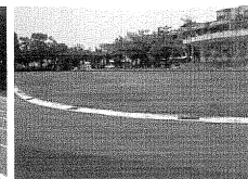
大寮區大寮國小PU跑道工程
