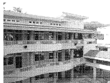
六龜區六龜高中校舍新建工程
