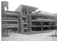
大樹區大樹國中校舍新建工程
