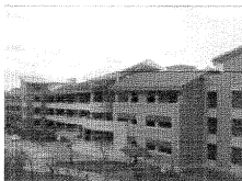
岡山區岡山國中校舍新建工程
