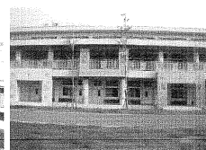
六龜區龍興國小校舍新建工程
