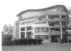
苓雅區成功國民小學第一期校舍改建工程
