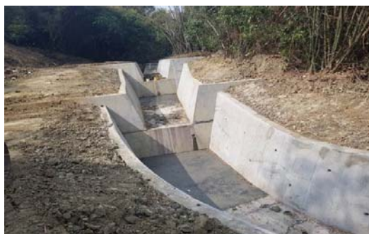
內門區中埔段 317 之 1 地號旁野溪整治工程
