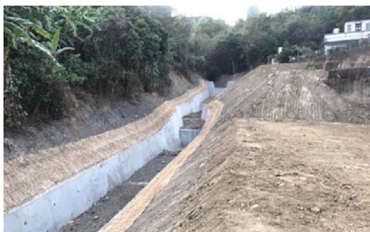
杉林區木梓里玄龍宮下方野溪治理工程
