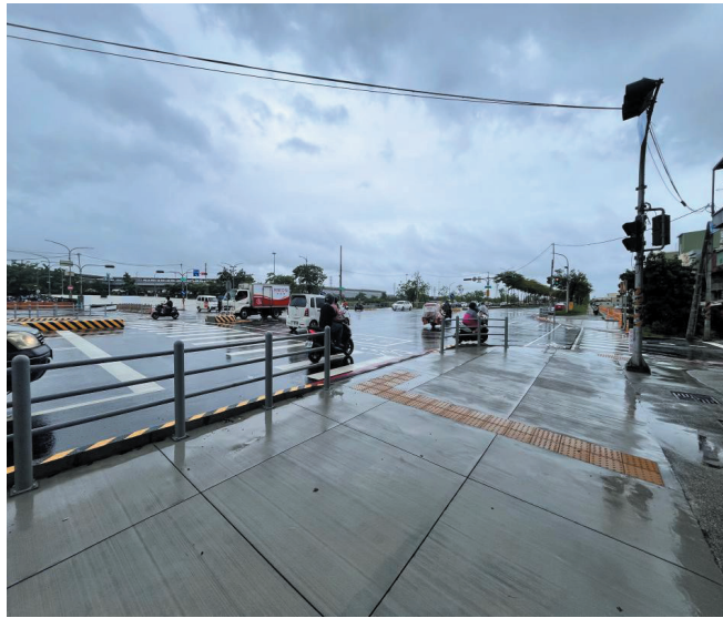
圖 10 捷西路/中正路阻隔設施
