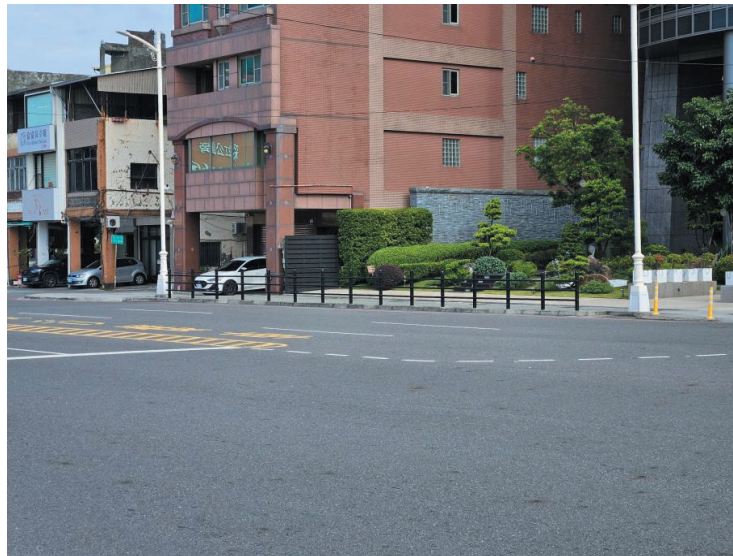
圖 9 海邊路/新田路阻隔設施
