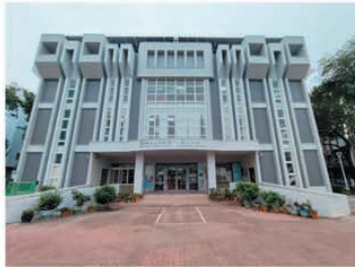
鳳山二館於113年12月完成補強
