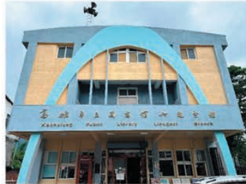
六龜分館於113年9月完成補強
