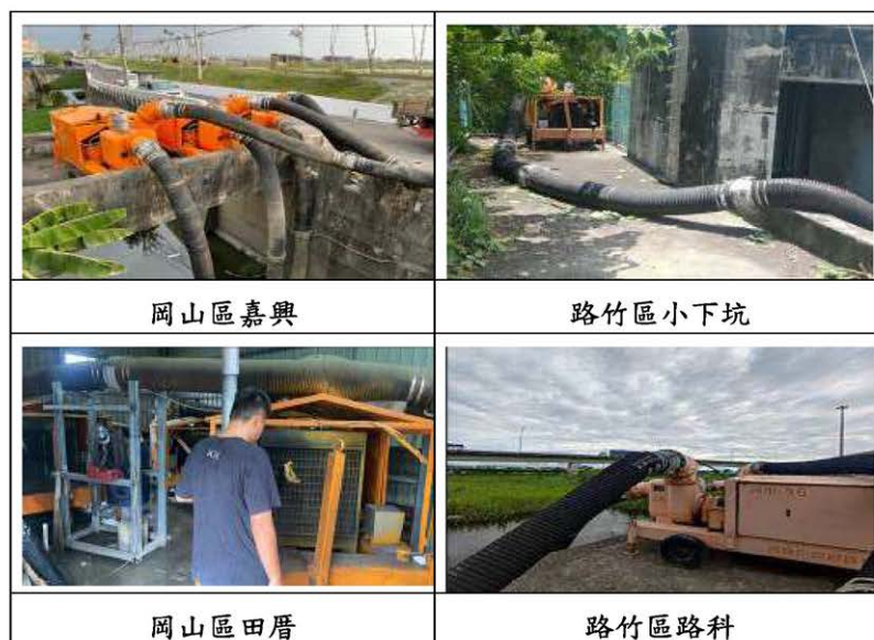
圖七 土庫排水(含岡山、路竹地區)大型移動式抽水機淹水救災情形
