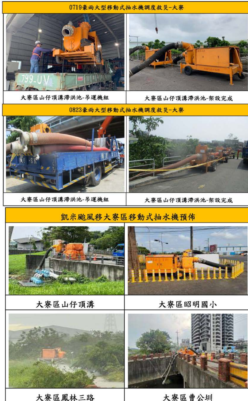
圖十 大寮地區大型移動式抽水機支援淹水救災情形
