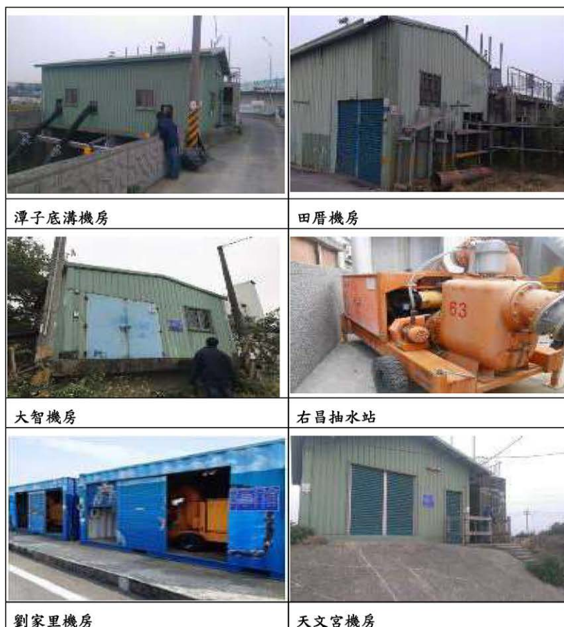
圖十二 抽水機房照片
