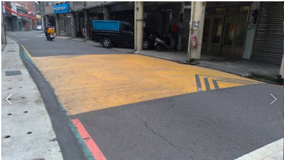
減速坡:寬度 6~7 米, 高度 10~20 公分。
