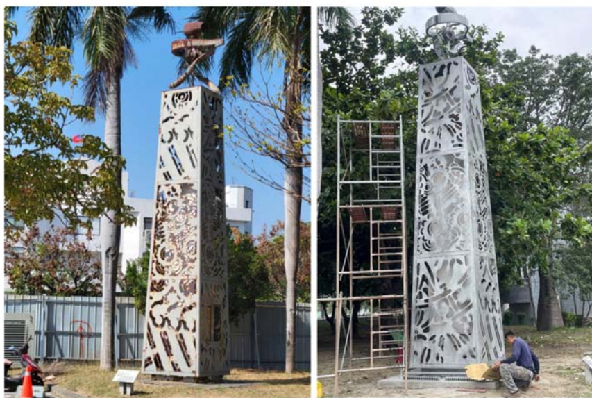
《文武山崗》除鏽拋磨、飾面噴塗修復
