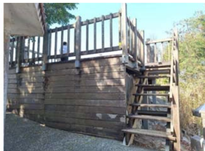
觀音亭旁觀景平台現況
