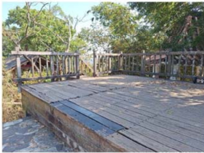
觀音亭旁觀景平台現況
