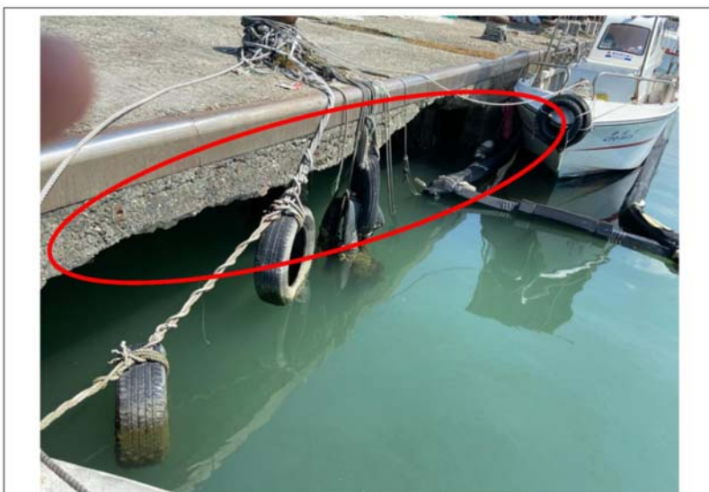
彌陀漁港北碼頭現況 2(冠牆斷落)
