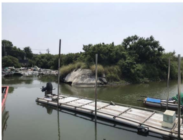
圖4 漁港西側土堤
