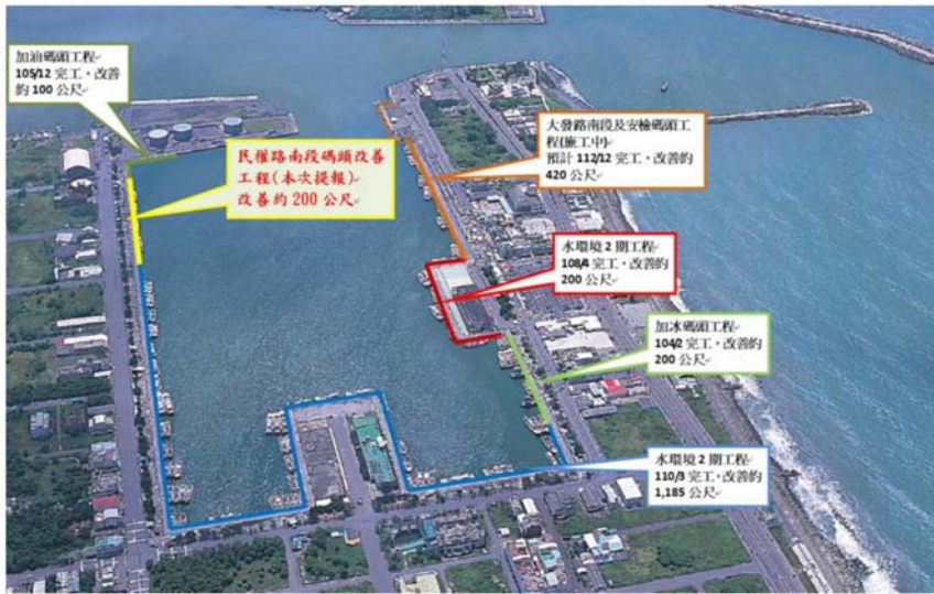
圖 4 興達漁港近海泊區近年來施工情形
