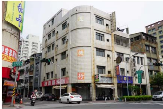
五福四路及新興街轉角建築樣貌
