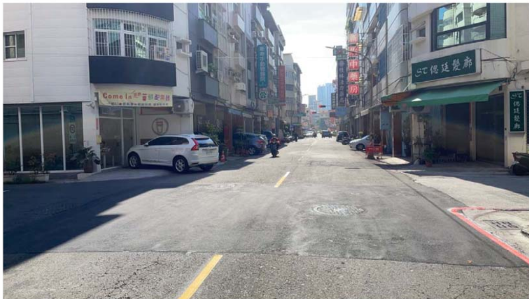
三民區永年街45號前復舊現況
