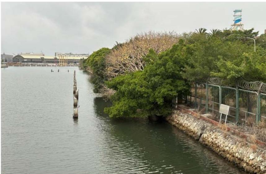
圖 2-11 五號船渠成功橋以下游右岸為砌石斜坡護岸與南部電廠設施
