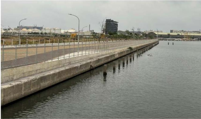
圖 2-10 五號船渠成功橋以下游左岸為直立式護岸與後方綠園道素地
