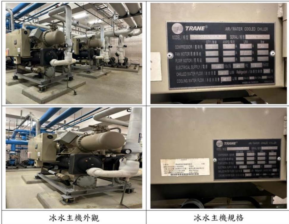
(B) 改善措施之結果：以降低空調系統能耗指標值改善作為基準，包含本項經濟部能源局公告蒸氣壓縮式冰水機組容許耗用能源基準與能源效率分級標示事項方法中的1級能源效率冰水主機，進行選購安裝汰換，及非優先項目冰水泵依負載需求變頻控制、冷卻水塔汰舊換新及變頻控制，**整體提高空調系統效率**。
