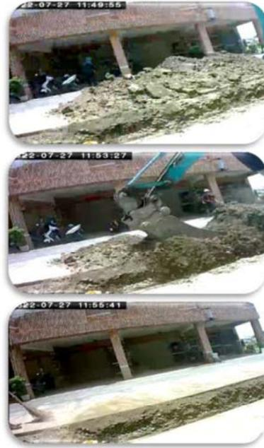
以原開挖土方作為回填材料施工情形
