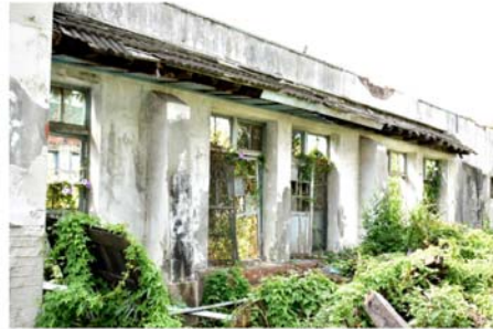
編號 009 建築現況
