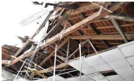
編號 009 建築內部現況
