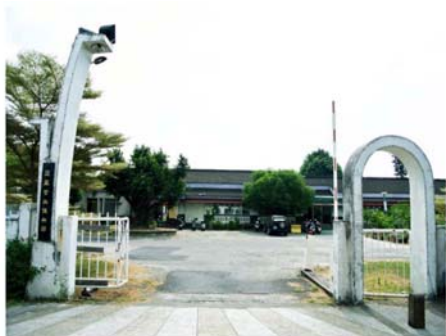
新生社 入口處現況
