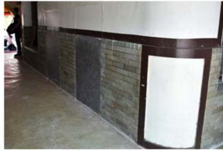
編號 004 建築內部面磚鋪貼
