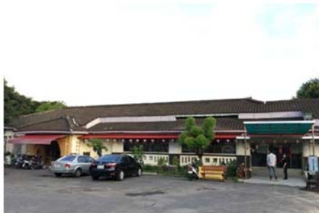
編號 004 建築現況
