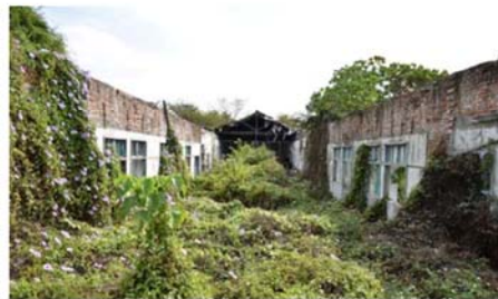
編號 009 建築內部現況
