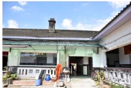
編號 004 建築現況
