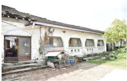
編號 009 建築現況
