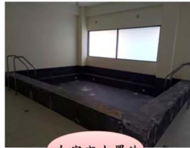
女室內大眾池
