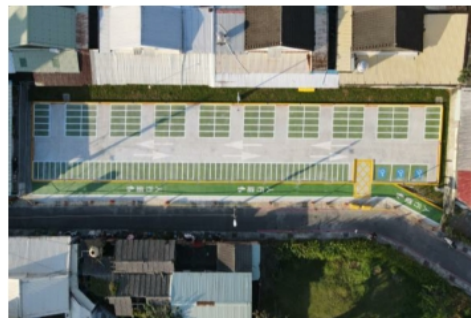
圖 30 鼓山區柴山公有機車停車場
