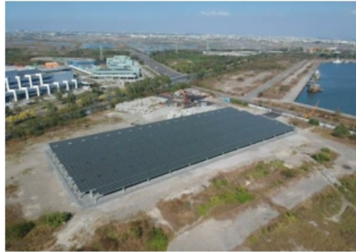
圖 44 茄苳停車場並附屬設置太陽光電發電設備
