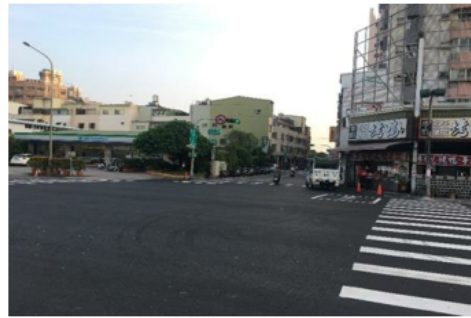
圖 3 號誌纜線地下化
