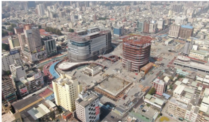
圖 10 高雄站區施工現況
