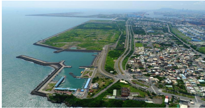
圖 1-新材料循環產業園區空拍圖
