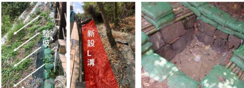
排水工程及砌石塊集水井
